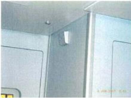
Die Lüftungsgitter rechts und links unten müssen offen sein und nach hinten ausblasen.
